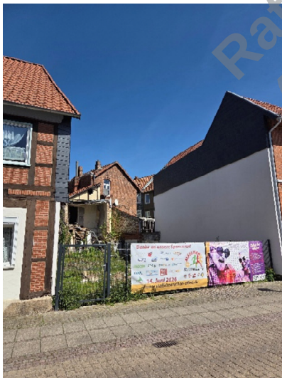
Abbildung 6: Baulücke Perkstraße (Quelle: NLG 2026)
