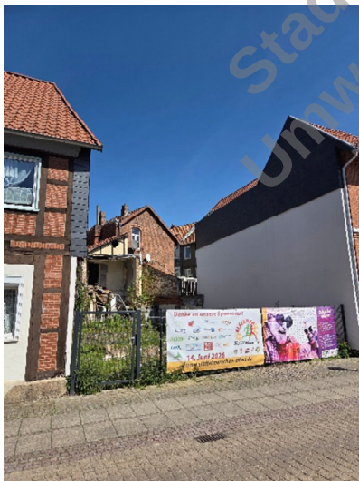
Abbildung 6: Baulücke Perkstraße (Quelle: NLG 2026)
