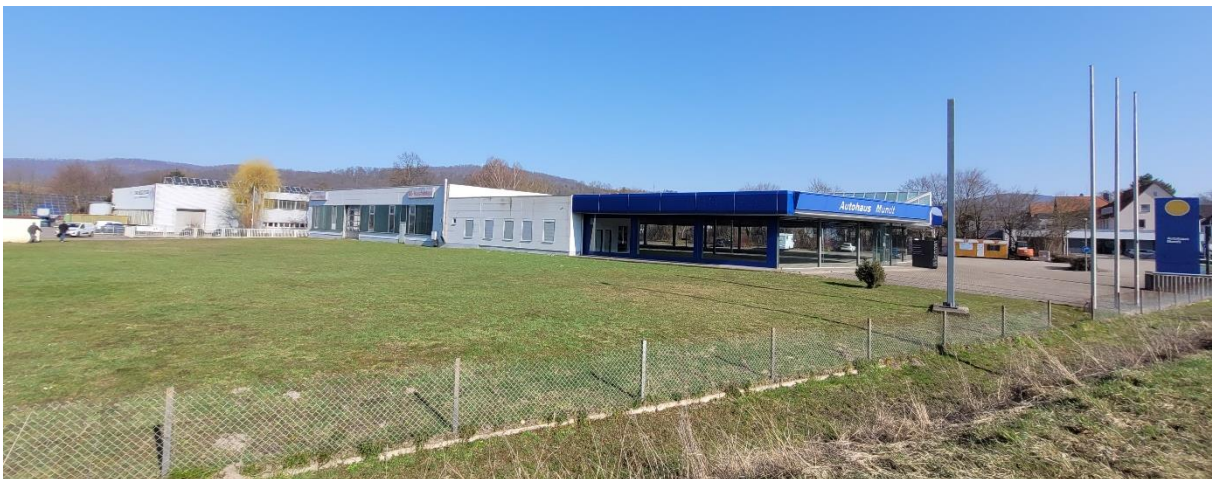
Abb. 5: Blick von der Landesstraße auf das Gebäude des ehemaligen Autohauses mit westlich angrenzender Scherrasenfläche (planerzirkel 03/2026)
