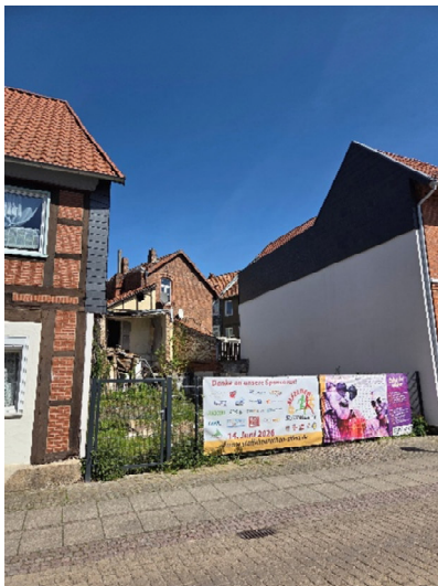
Abbildung 6: Baulücke Perkstraße (Quelle: NLG 2026)
