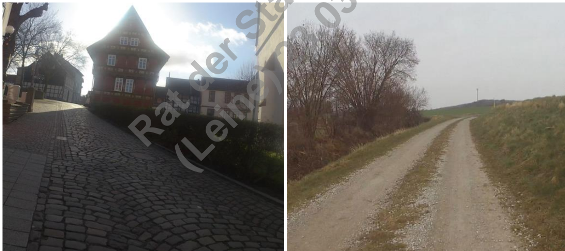
Abbildung 29: Beispiel für mangelnde Oberflächenbeschaffenheit (links: Grobes Pflaster, Über der Kirche; rechts: Wassergebundene Wegedecke, Wirtschaftsweg Imsen)
