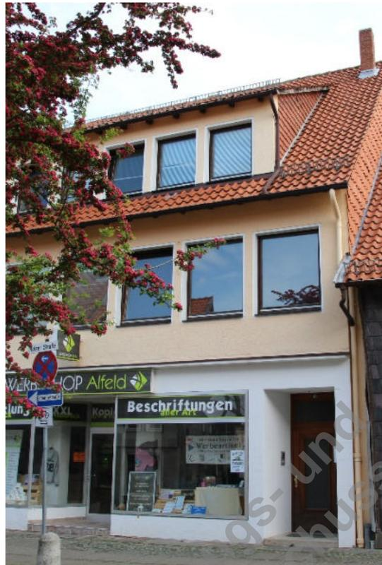
**Abbildung 40: Instandsetzungsbedürftige Fassade, nicht gegliederte Fenster, Fensterformat überformt (Quelle: NLG, 2022)**
