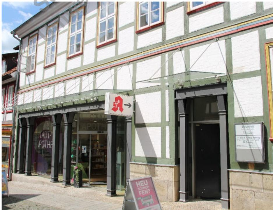
**Abbildung 41: Metallsäulen als Gestaltungselement in der Tragwerkskonstruktion (Quelle: NLG, 2022)**
