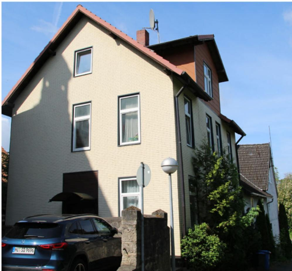
Abbildung 39: Fassade mit großformatigen Kunststoffklinkerplatten überformt und ungeteilter Fenster (Quelle: NLG, 2022)
