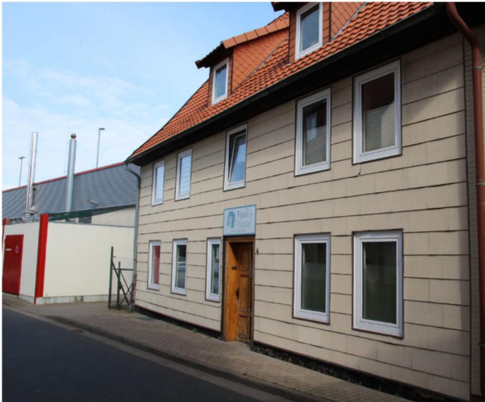
Abbildung 38: Mit Eternitplatten überformte Fassade (Quelle: NLG, 2022)
